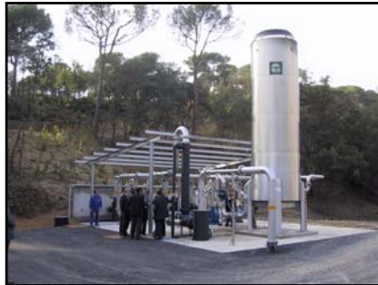
ANTORCHA Y PLANTA DE COMBUSTIÓN
